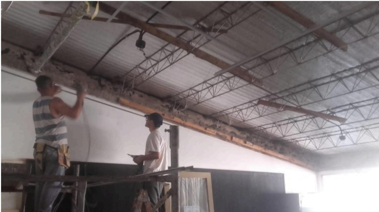
Además del remplazo de la cubierta existente por otra nueva, la intervención a cargo de la firma Full Home SA contempla la reparación integral del sistema eléctrico del edificio escolar, incluido el nuevo cableado.
