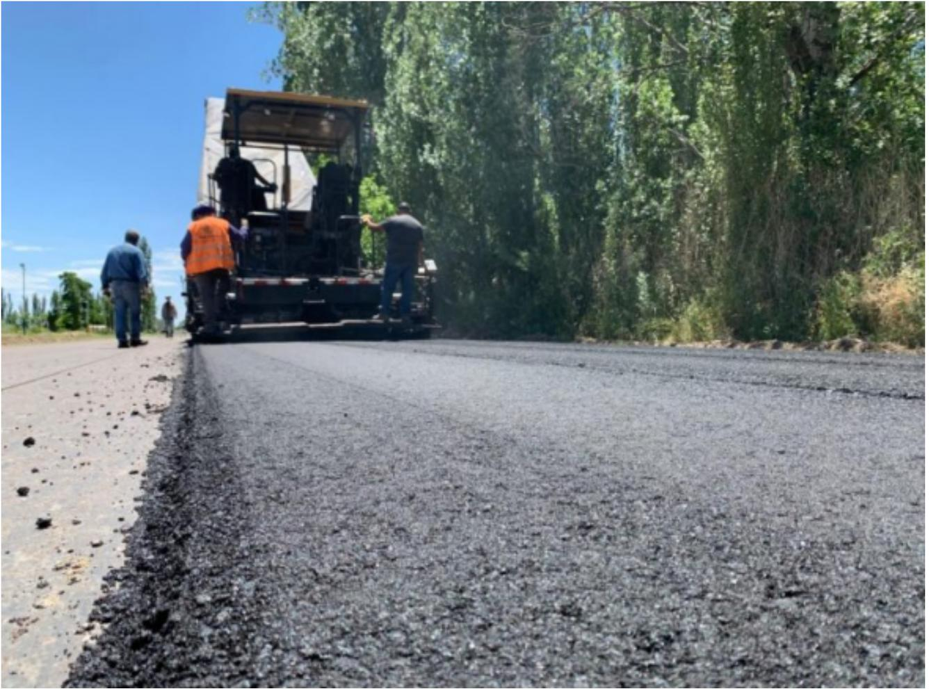
Se trata de un tramo muy deteriorado por el paso del tiempo que demandaba una nueva capa de carpeta asfáltica para mejorar y garantizar la transitabilidad de una vía muy utilizada por los vecinos de la zona, que les permite evitar ingresar a la Ruta Nacional 40.
